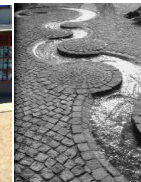
_rain garden_ cisterne e canali per la raccolta dell'acqua piovana
